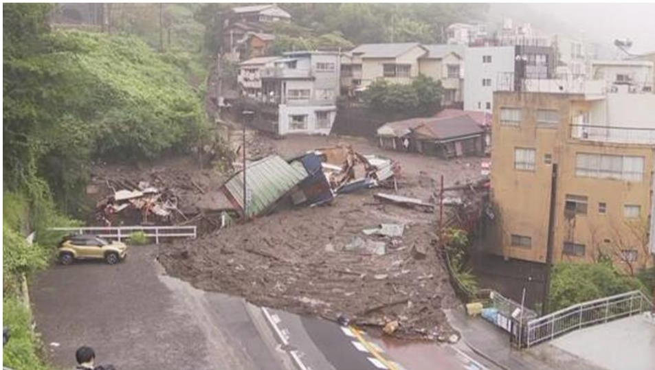
国道135号 (伊東方面から湯河原方面を見る)
