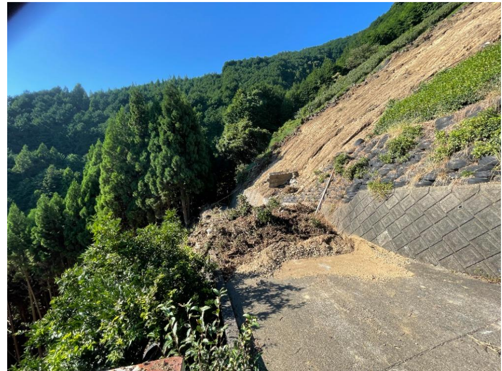
崩落斜面の中間点の状況
