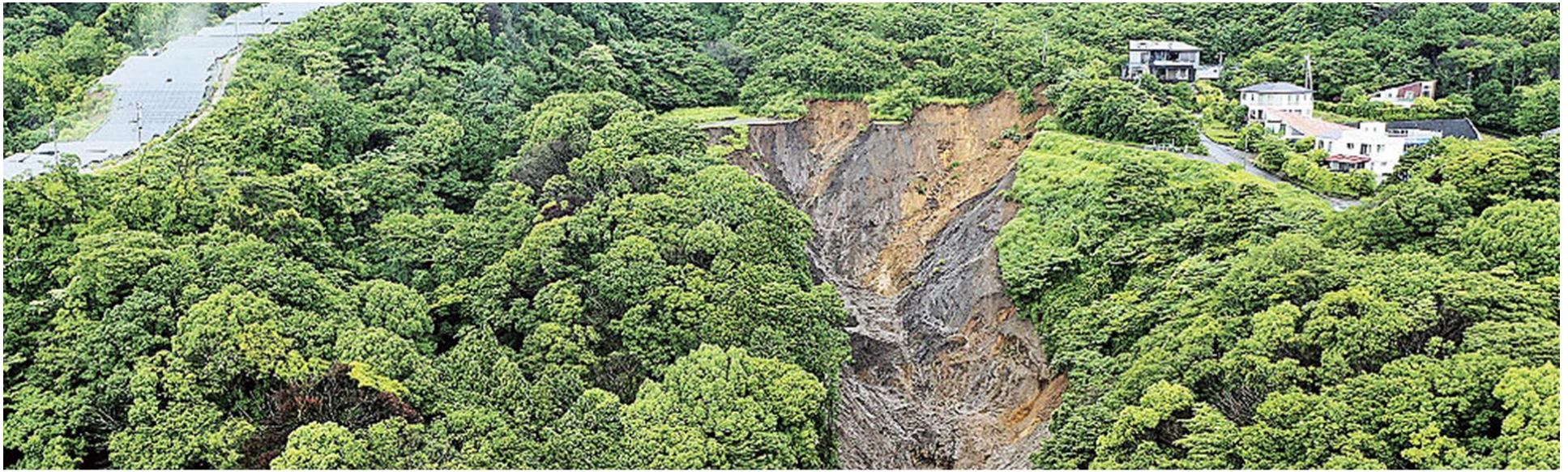
逢初川源頭部 (土石流の起点)
