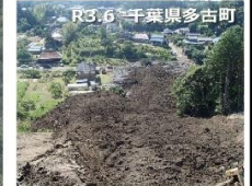
廃棄された土石の崩落 死者1名、重傷者1名、 軽傷者1名、県道通行止め 住宅被害1棟
