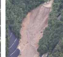
廃棄された土石の崩落 死者1名、重傷者1名、 軽傷者1名、県道通行止め 住宅被害1棟
