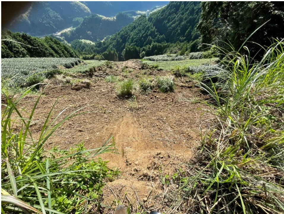
崩落の起点となった布沢源頭部の状況
